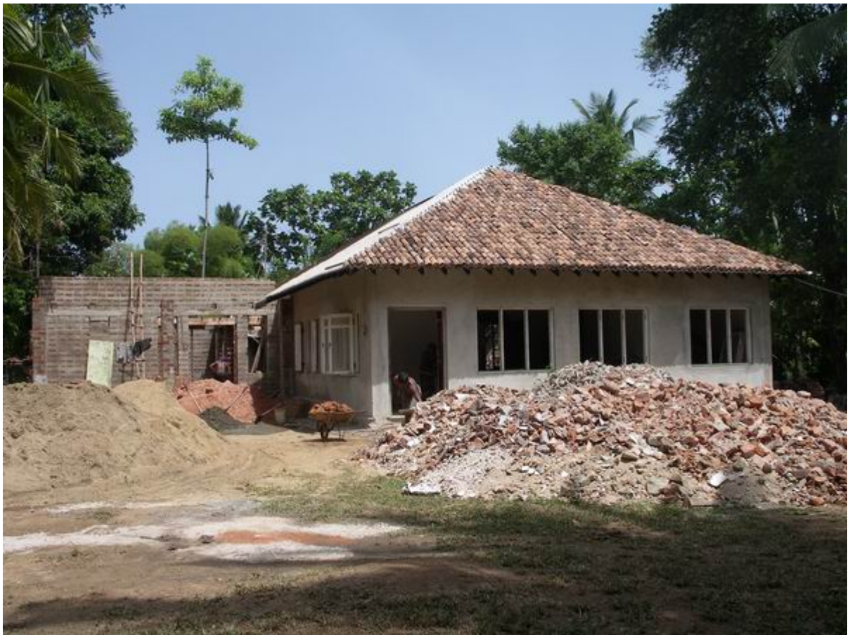
Nach dem Abbruch des Nebengebäudes
