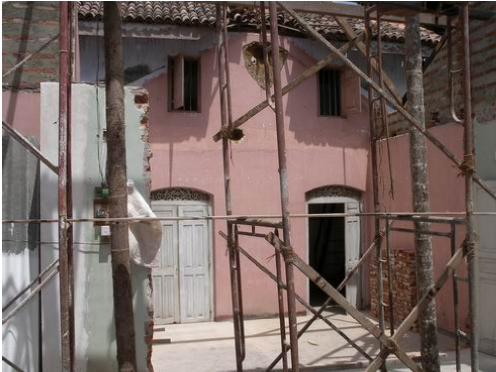
Das inzwischen abgebrochene Nebengebäude
